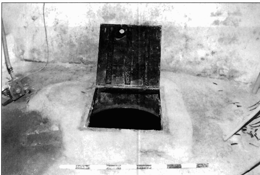
Foto 14: Detalle del primer depósito de decantación de aceite (20).
