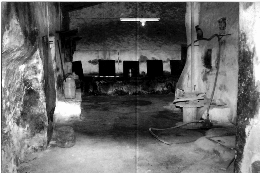
FOTO 17: Situación de los depósitos de decantación (20-22), hogar (24), rebancos (23 y 25), y al fondo, los tinajeros (26).
