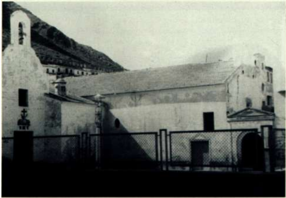
Exterior. Convento de Alcantarinos. Callosa de Segura.
