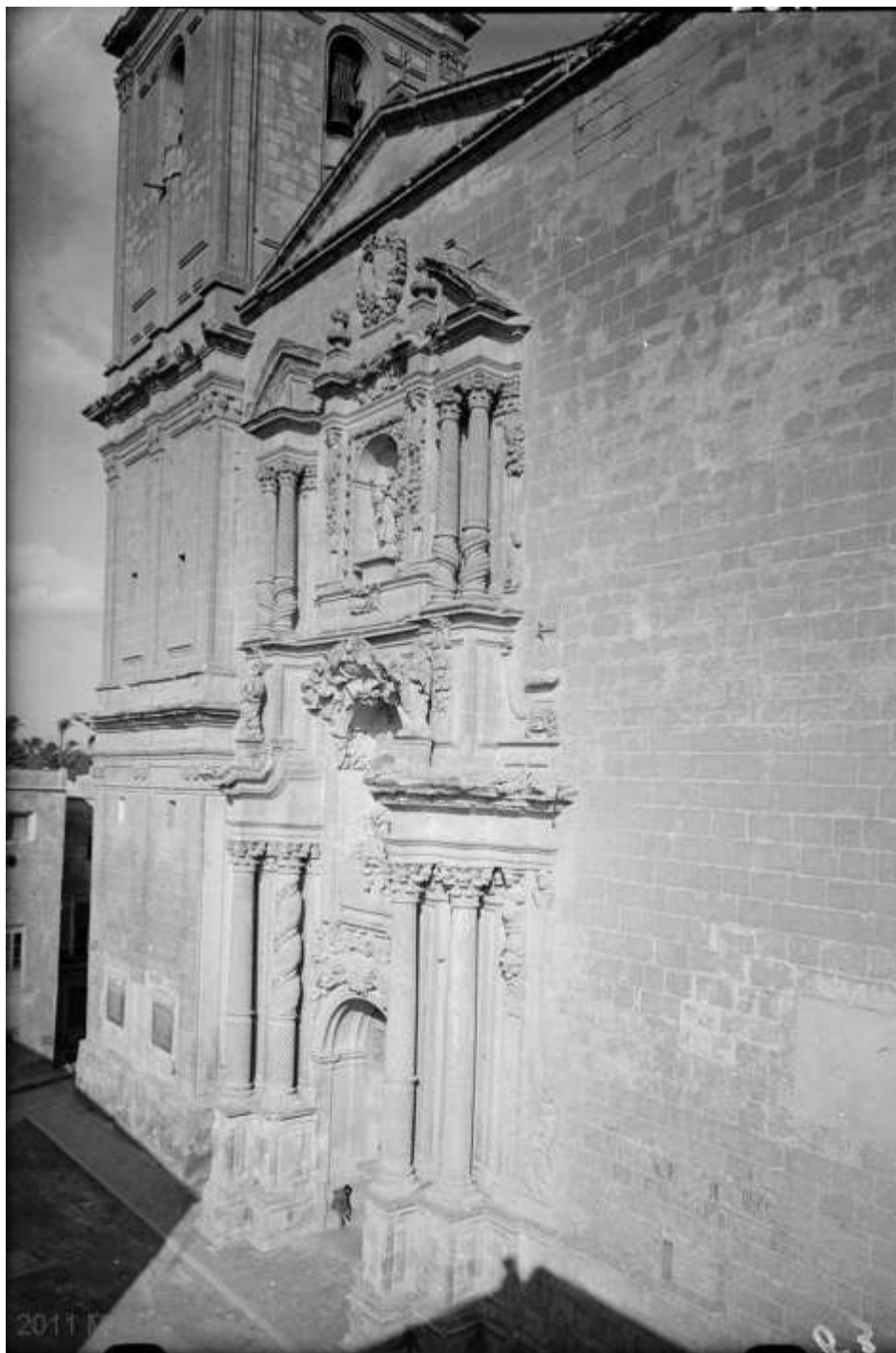
Fachada. Iglesia de Santa María. Elche.
