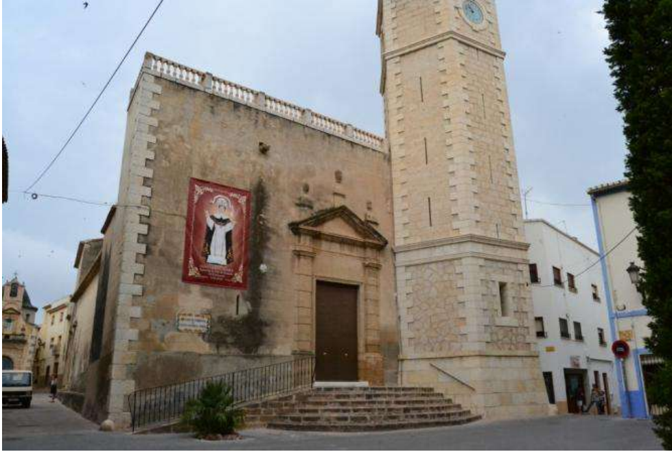
Exterior de la iglesia de Santa Catalina. Teulada.
