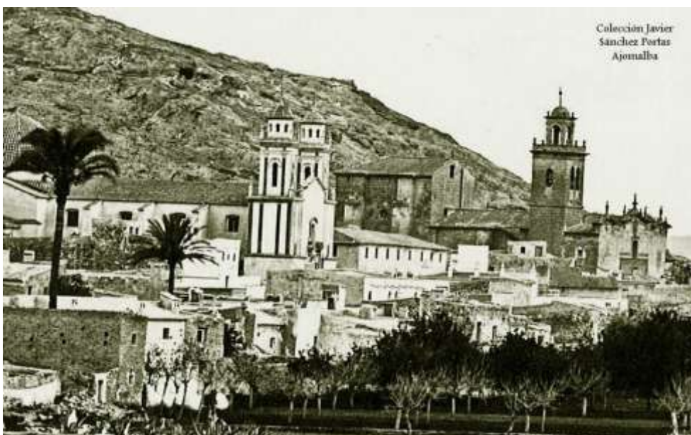
Vista exterior. Iglesia de Santiago. Orihuela.
