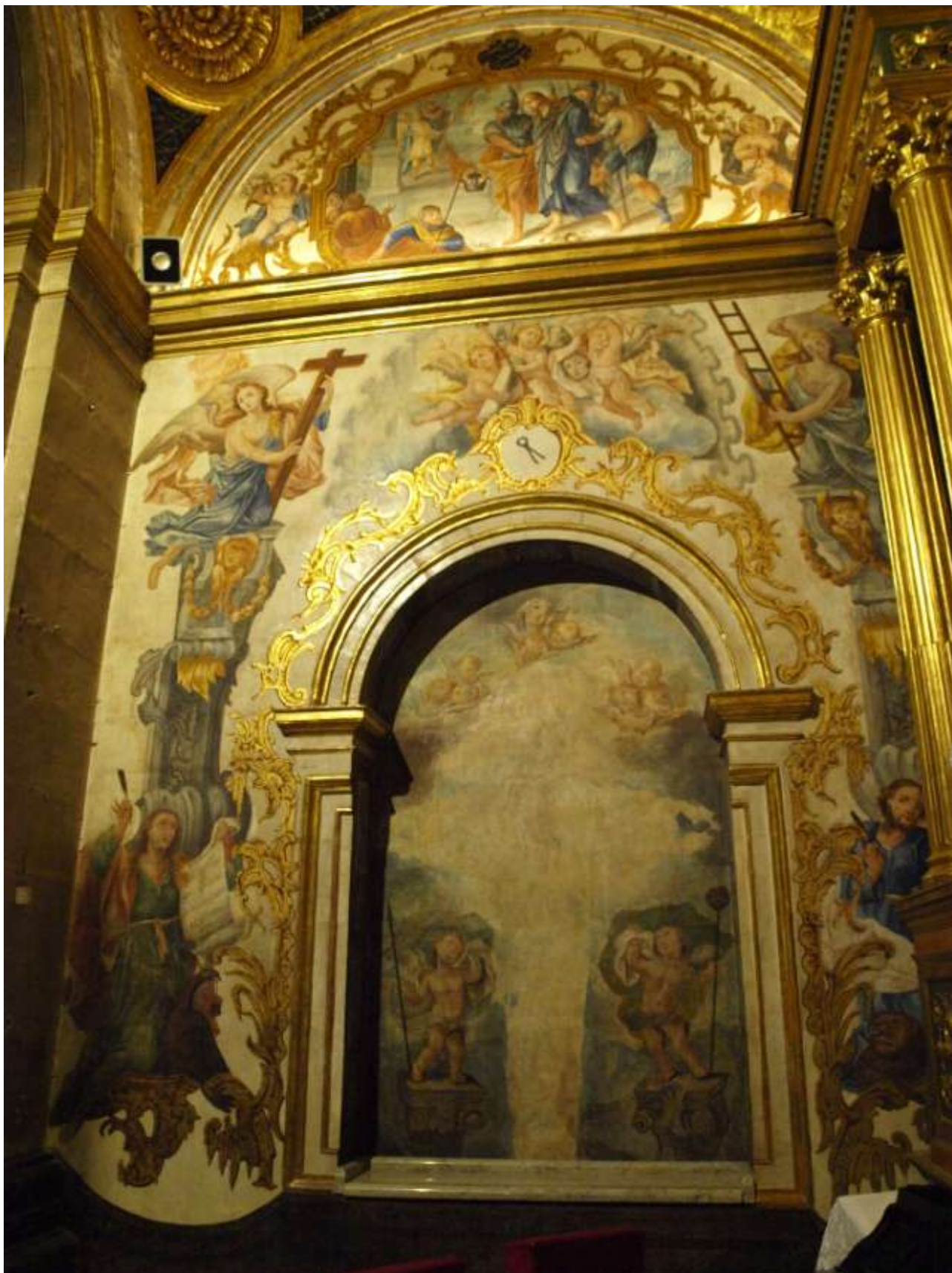
Muro norte de la capilla de la Purísima. Iglesia de San Martín. Callosa de Segura.
