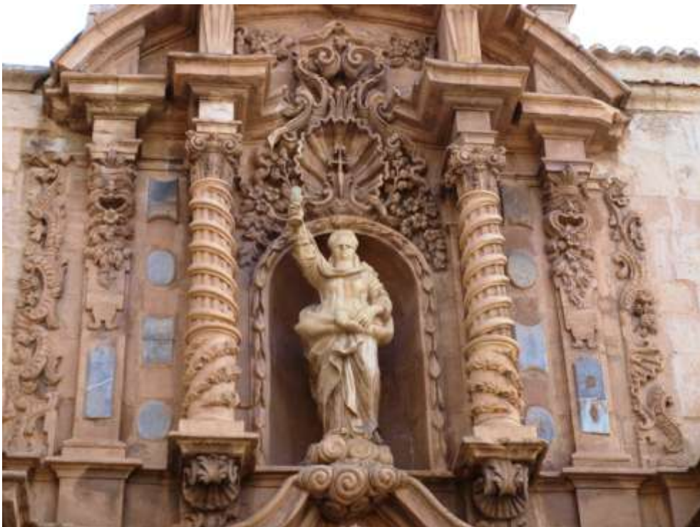
Detalle del cuerpo superior de la portada. Capilla de la Comuni3n. Iglesia de Santiago. Orihuela.
