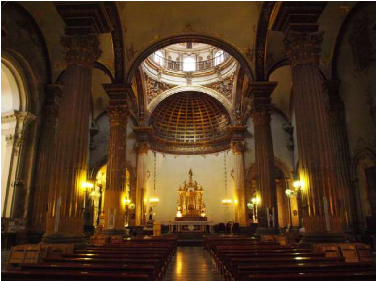
Interior de la iglesia de San Martín. Callosa de Segura.
