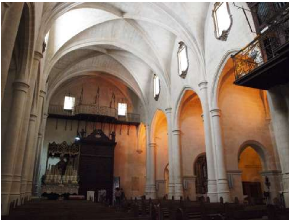
Vista lateral de los contrafuertes perforados. Iglesia de Santa María. Alicante.
