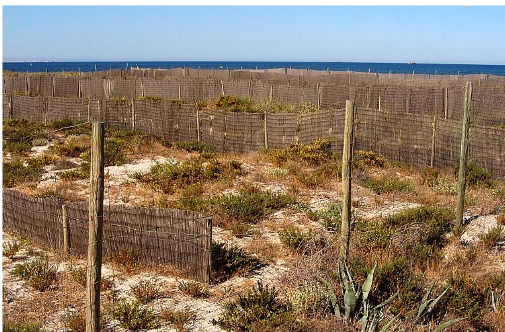
Figura 92. Captadores de arena en la playa de la Torre Derribada.
