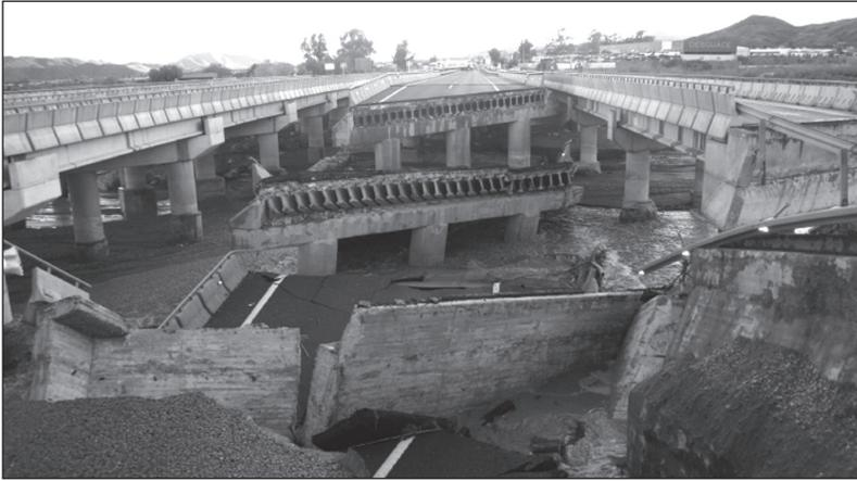
**FIGURA 9. La avenida de la Rambla de Béjar del 28/09/2012, destruyó un vial del Puente de la A7, pk 584.**
