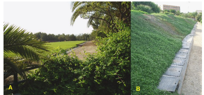
Fig.2: Detalles del sistema de depuración. En “A”, aspecto de la cobertura vegetal de los lechos, con la línea de arquetas de alimentación y vegetación circundante. En “B”, se observa el talud que limita los lechos, ajardinado con planta de soporte de suelo, y las arquetas de drenaje de las distintas fases en su base.
