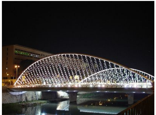
Puente del hospital Reina Sofía.
