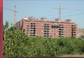
Las constructoras se ceban con la Huerta en el ensanche norte de Murcia.
