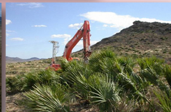
Las excavadoras destruyen Palmito en el Carmolí.
