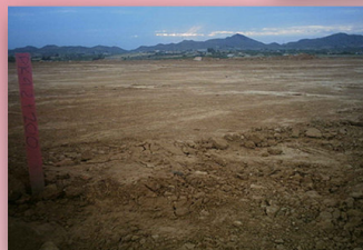
La autopista Cartagena-Vera destruye los alrededores de Miranda.
