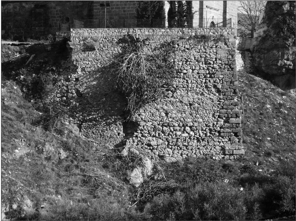
Figura 6. Paramento oriental de la torre 4 construido en mampostería encintada.
