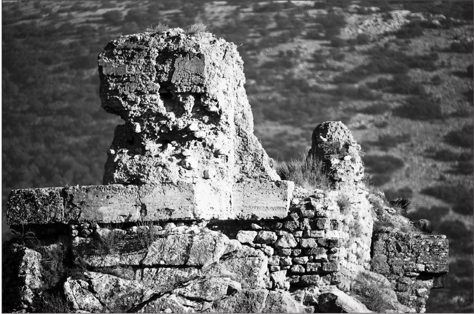
Figura 4. Detalle de la torre 1. Se aprecia que apoya en la estructura denominada E 8, y como la torre 2 (a la derecha) es posterior, apoyándose en la torre 1.
