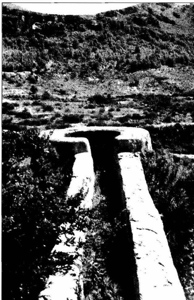
Foto 2. Caz y boca del cubo del molino Huertas.
