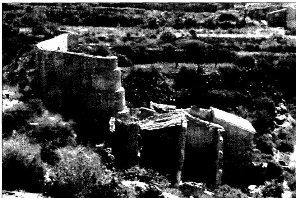
Foto 4. Conjunto del molino Nuevo, con su caz elevado, el cubo y el casal.
