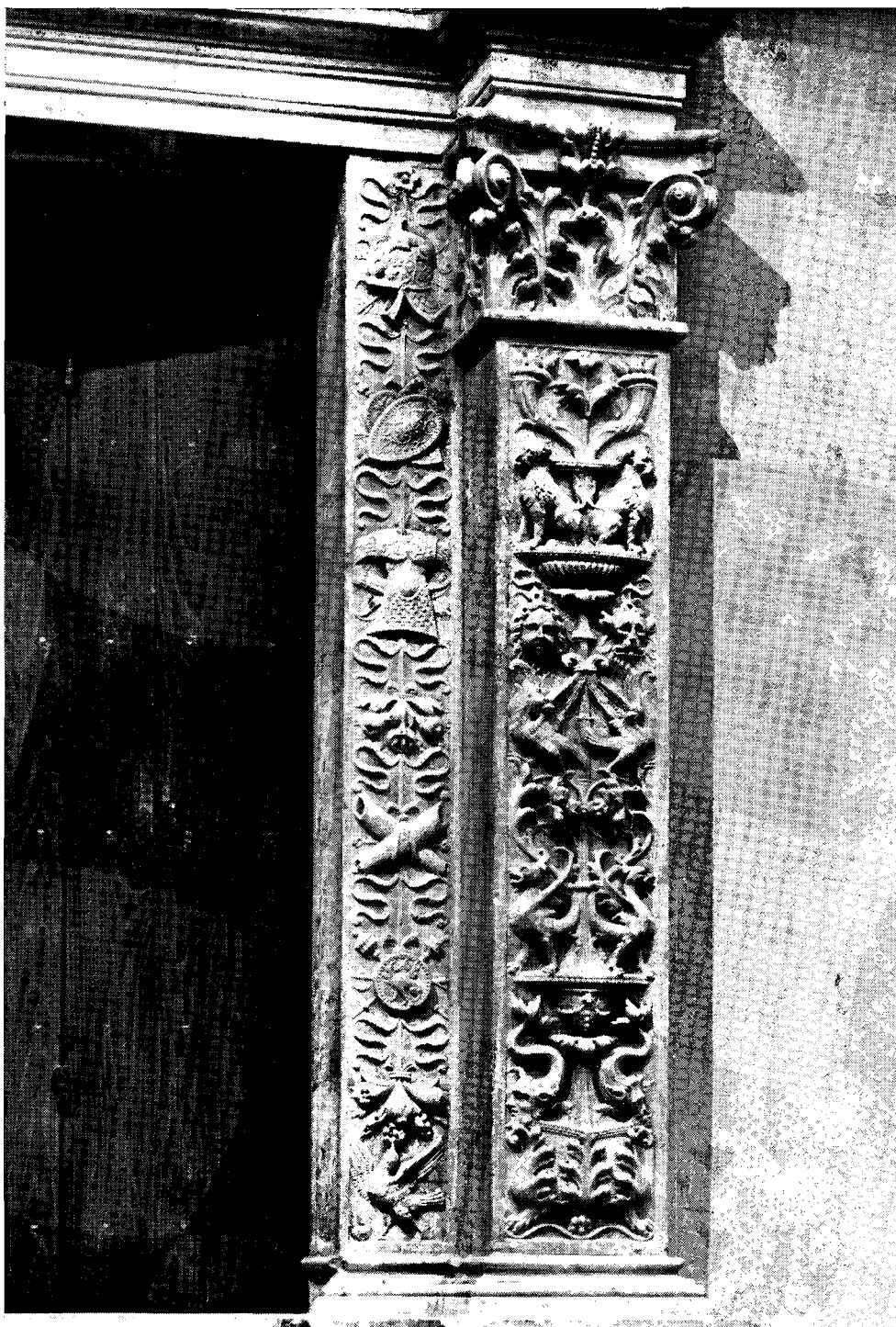
Fig. 31.—Pilastras de las ventanas
