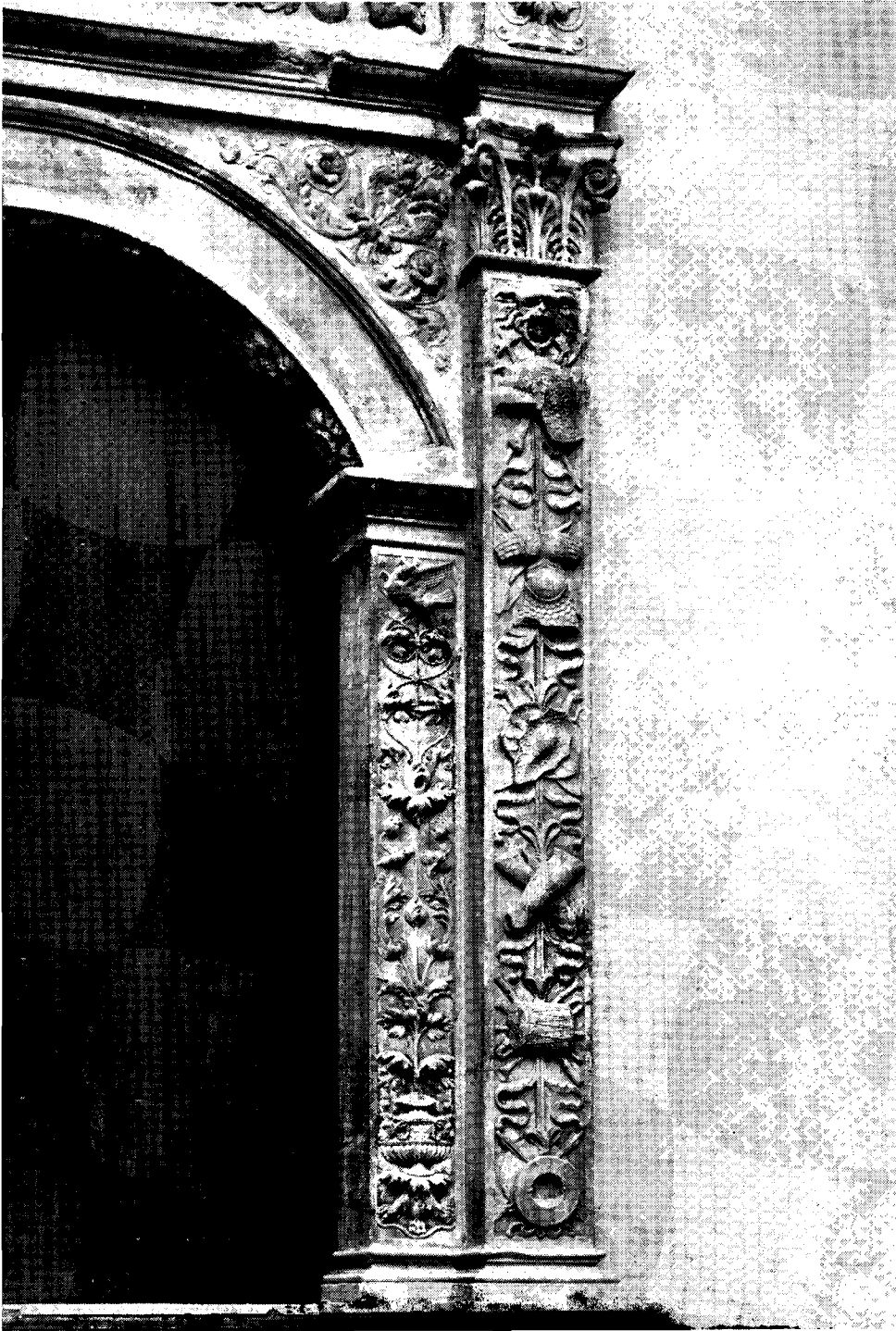
Fig. 33.—Pilastras de las ventanas
