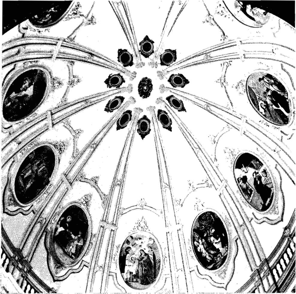
LAM. 4.—Cúpula de San Juan de Dios. Vista parcial.
