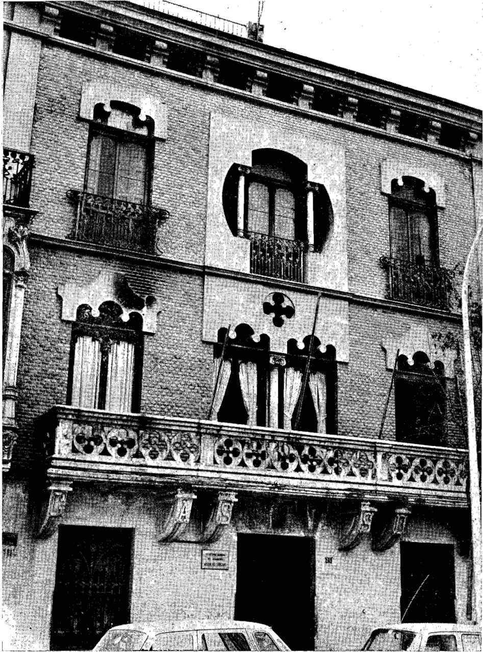
LAM. 17.—Casa de Díaz Cassou. Fachada principal a la calle de Santa Teresa.
