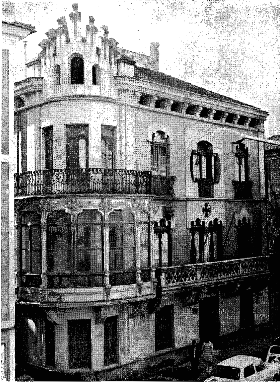
LAM. 13.—Casa de Diaz Cassou. Perspectiva frontal. En primer término, a la izquierda, la casa n.º 29 antes de su demolición.
