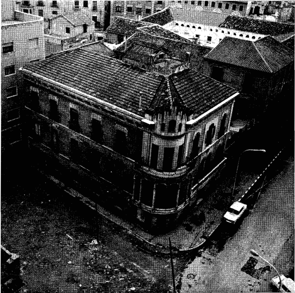
LAM. 12.—Ubicación de la casa de Díaz Cassou en la calle de Santa Teresa, al fondo, a la derecha, el Hospicio.
