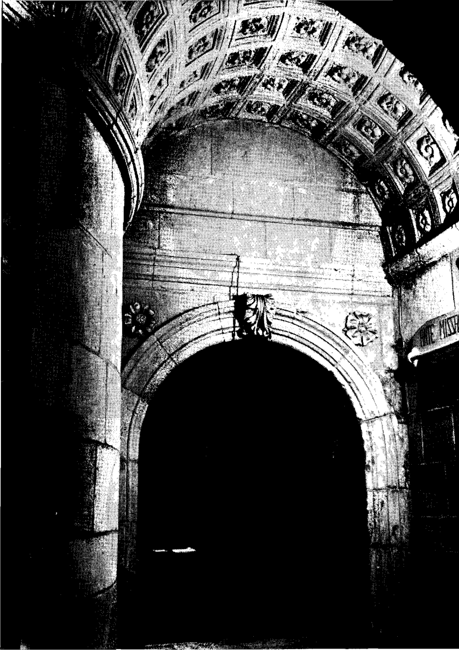
FIG. 6.—Catedral de Murcia. "Detalle de la bóveda en esviaje del tramo de acceso a la Sacristía".
