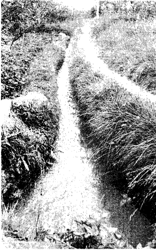
LAM. I, FIG 1: La "hilera", conducto menor que parte de las acequias y dá origen a los "brazales". Obsérvese como las vías de penetración más elementales de la Huerta (las sendas) siguen las márgenes de estas vías de conducción de agua.
