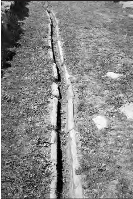
TAFEL 4A: Qanawat, Theater, unterirdischer Kanal im Bühnenhaus.
