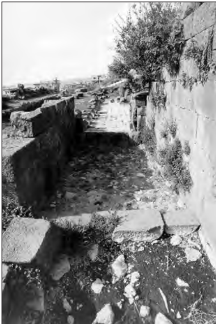
TAFEL 4C: Qanawat, Theater, südlicher „Durchgang“ mit Wasserbecken.
