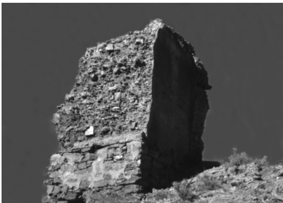
Fig. 3.-Tapial de calicantos. Castillo de Alquife
