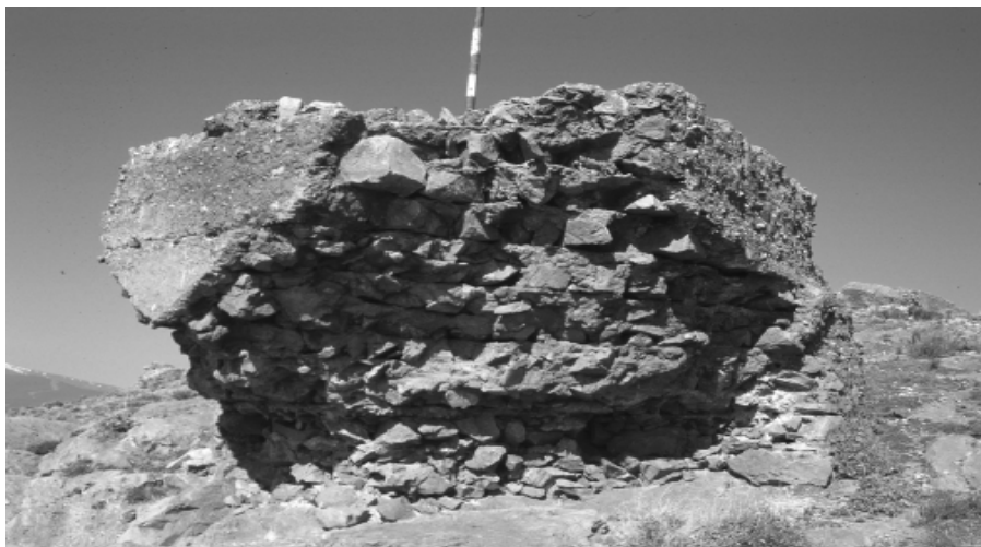
Fig. 3.-Tapial de calicantos. Castillo de Alquife
