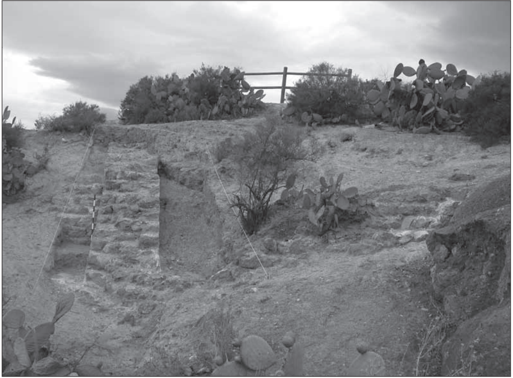
FIGURA 5. Muralla lado Sur y ángulo SE.
