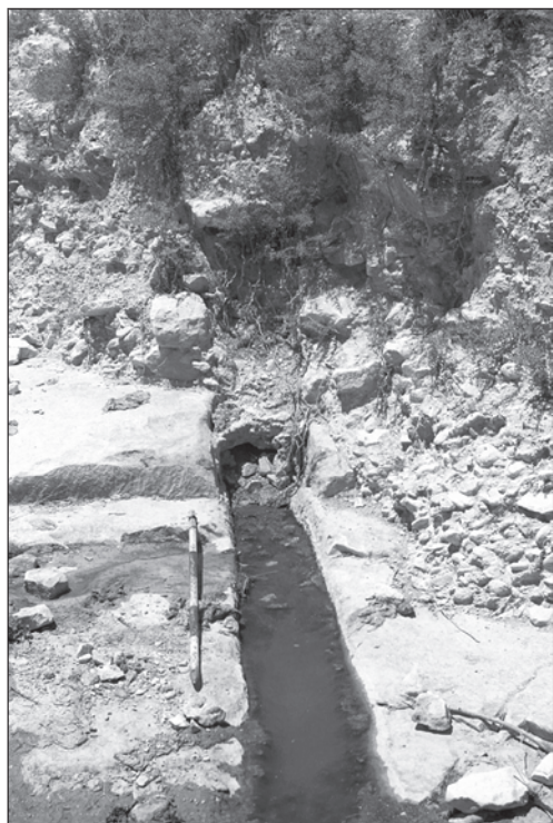
FIGURA 110. Wādī Ŷurum. Boca de acueducto casi cegada
