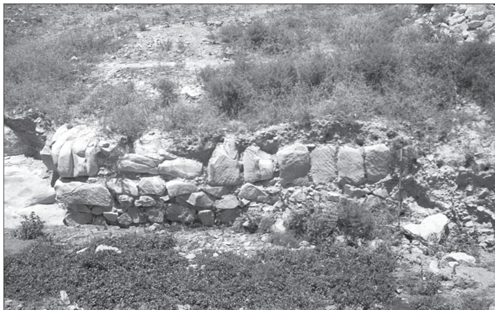
FIGURA 113. Wādī Yūrum. Unidad Constructiva n° 2
