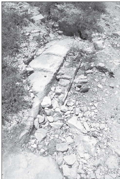
FIGURA 109. Wādī Ğurum. Estructura romana en superficie
