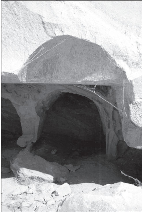
FIGURA 22. QM A-1. Fachada. Detalle
