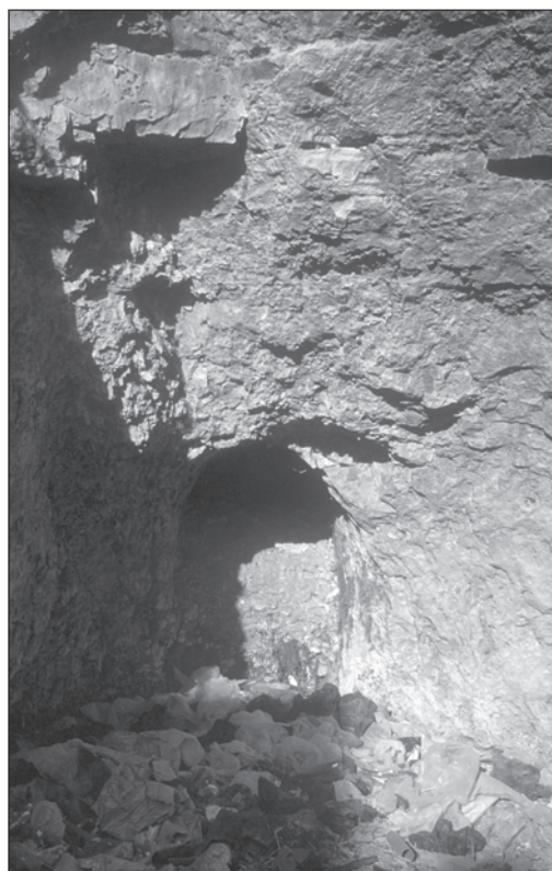
FIGURA 244. Al-Qāra. Boca cegada del acueducto
