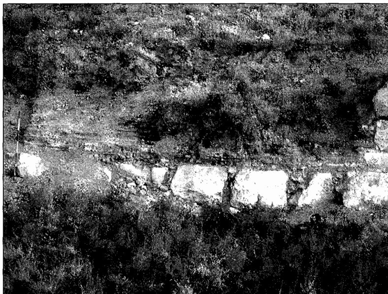
FIGURA 2. Detalle de la figura anterior, en el que se ve el revestimiento marmóreo de la estructura y la estructura de ladrillos del núcleo interior de la obra.
