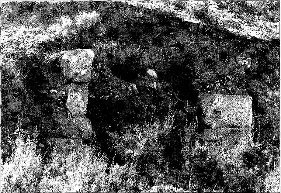
FIGURA 4. Otro detalle que deja ver mejor toda la estructura constructiva del conjunto.
