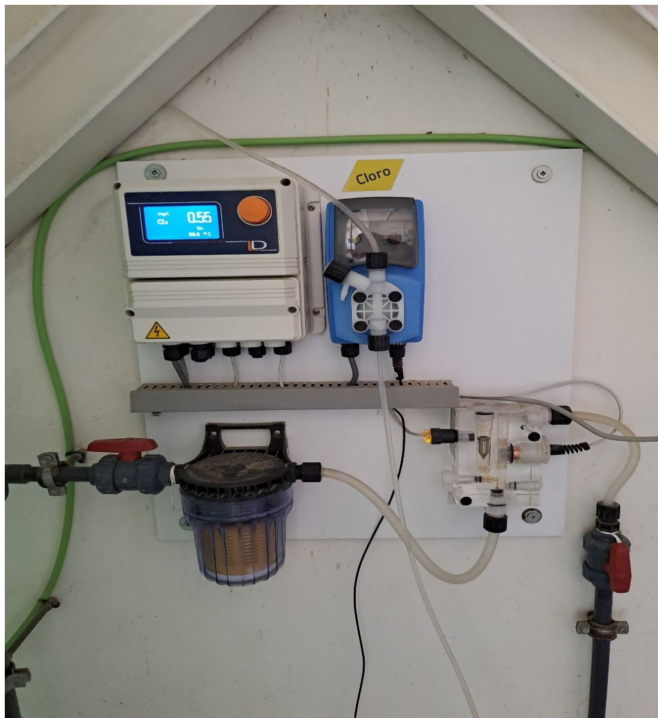
Figura 21: Sistema tipo de cloración automática a base de hipoclorito sódico. Fuente: Autor.
