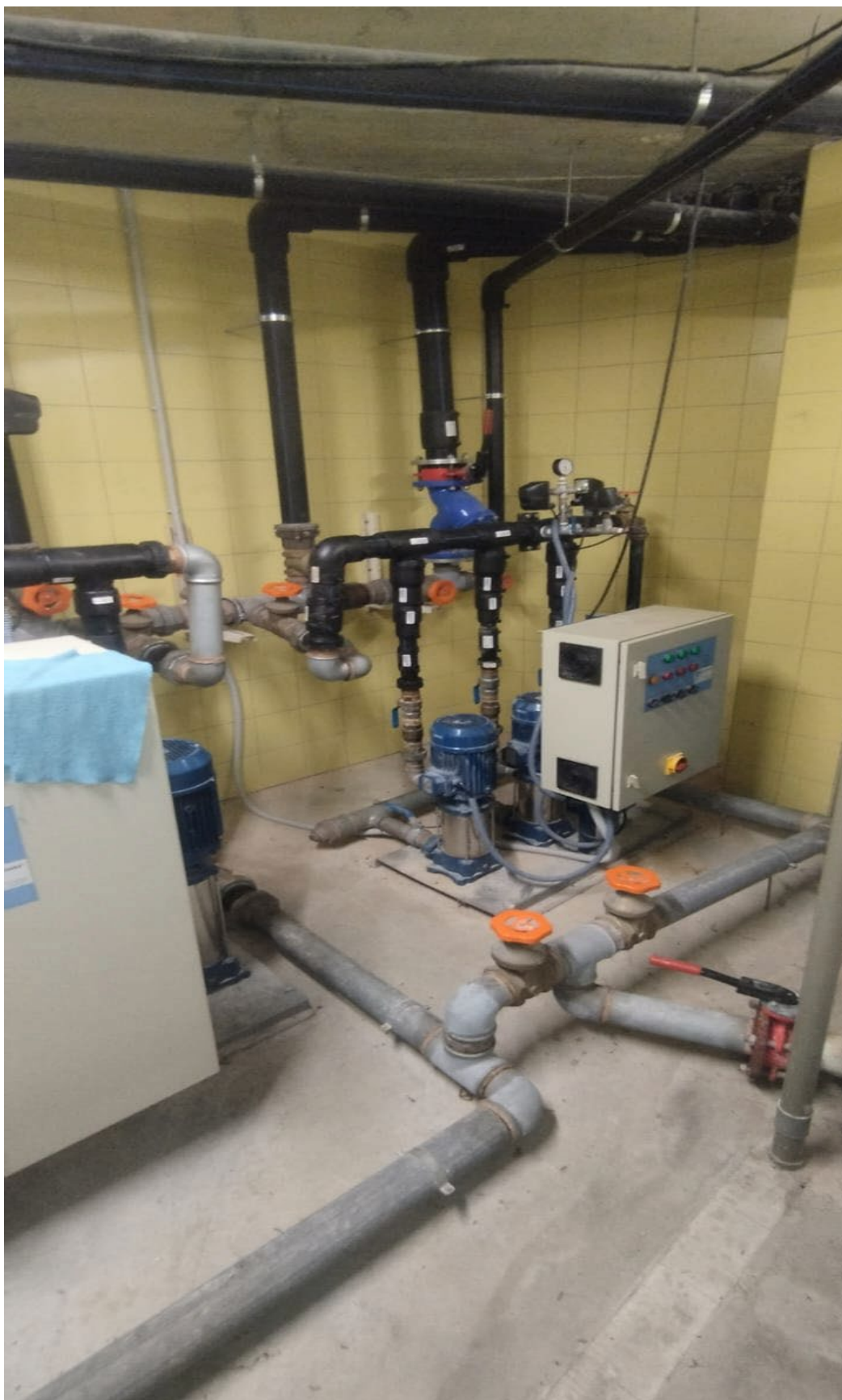
Figura 28: Estructura de mezclado final de ACS y AFCH. Fuente: Autor.
