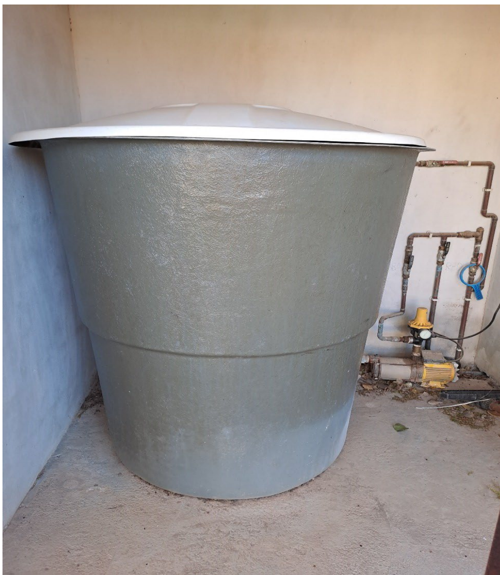
Figura 20: Estación de tratamiento de agua potable. Fuente: Autor.
