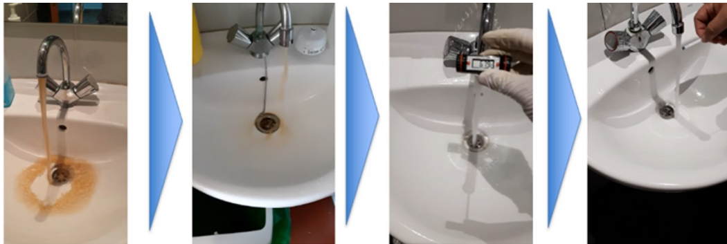
Figura 60. Fotos del proceso de limpieza fisicoquímica de redes de fontanería. ACS.HG.
