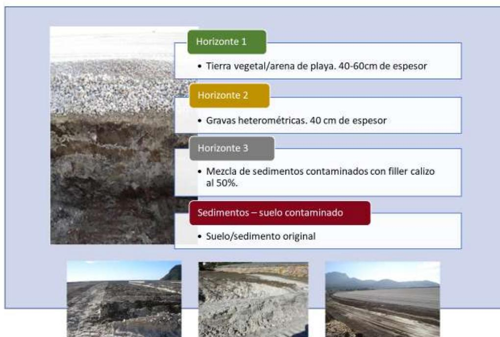
*Figura 1.29.- Esquema de tecnosol realizado para el proyecto piloto de recuperación de la Bahía de Portmán.*
