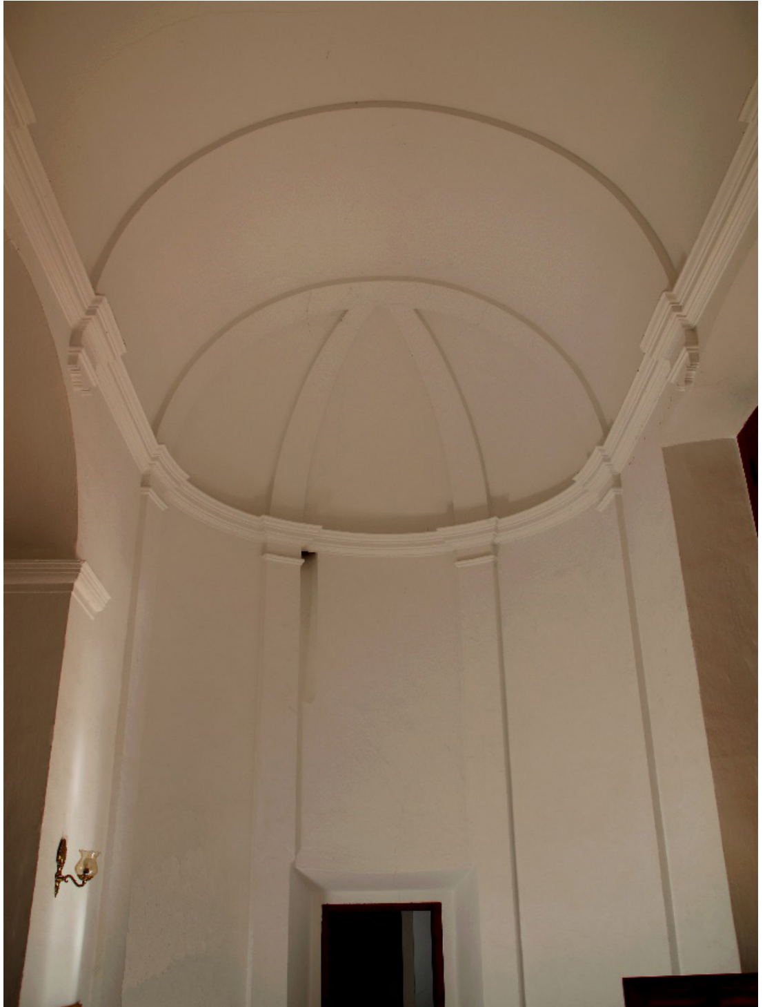
Figura 4. Atrio de entrada al inmueble. Iglesia de Alpandei. Fotografía del autor.
