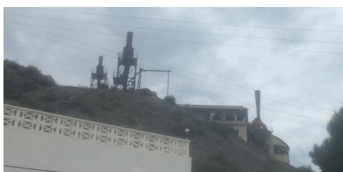
Figura 48: Vista del lavadero Roberto desde la carretera. (Elaboración propia)
