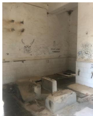
Figura 53: Interior de una de las instalaciones pertenecientes a la batería. (Elaboración propia)
