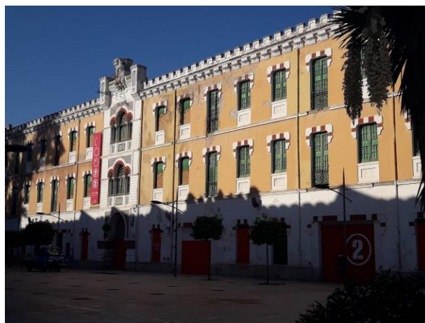
Fig.1 – Pabellón Dos, Cuartel de Artillería de Murcia. Fuente: Autor
