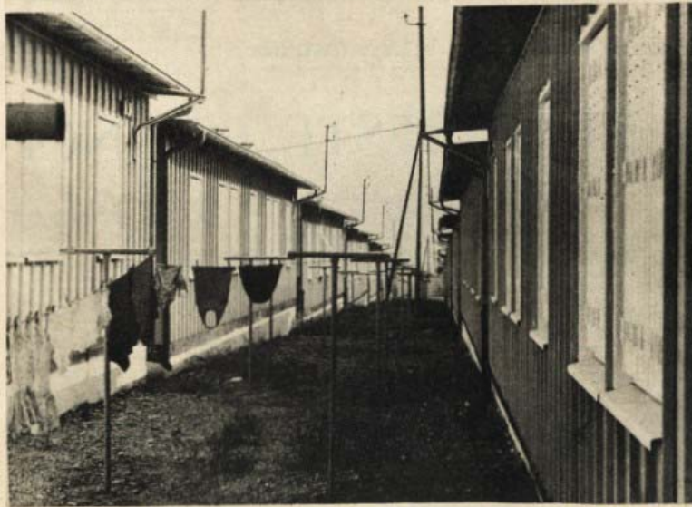
Casas prefabricadas en Puerto Lumbreras (patio interior). Las casas están construidas con plancha metálica en los techos y paredes exteriores. La chapa se recalienta con el sol, convirtiendo el interior en un auténtico horno.
