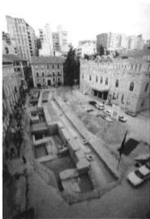
Excavación de un tramo de la muralla de Murcia en la Plaza de Romea.
