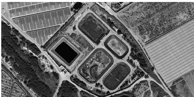
FIGURA 4 DEPURADORA ABANDONADA DE MAZARRÓN. ESTADO INICIAL DE LAS OBRAS
