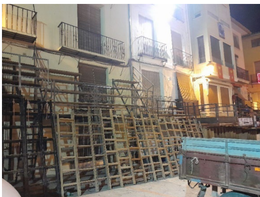
Fig. 32. Montaje de la plaza, escaleras.
