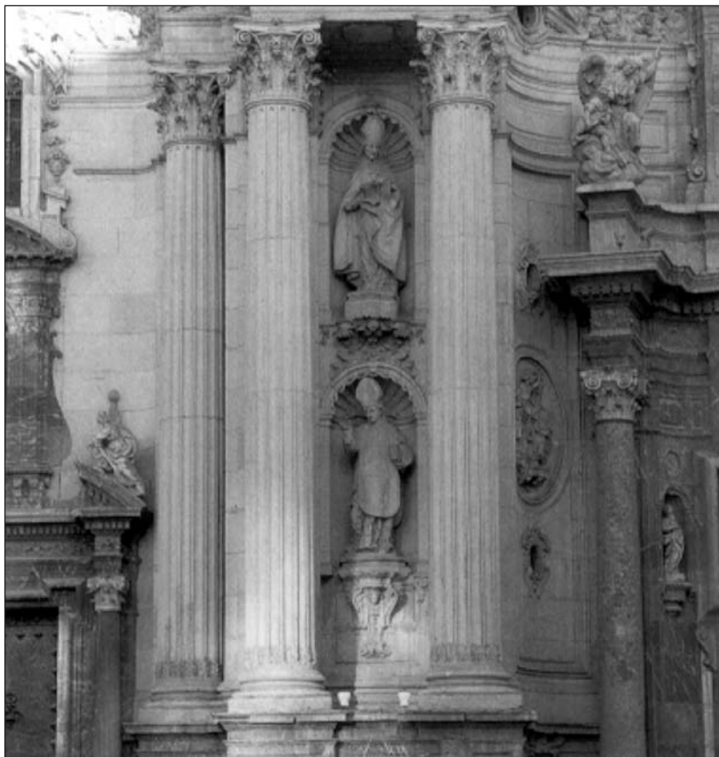
FOTO 1. Detalle de la fachada de la Catedral de Murcia.
