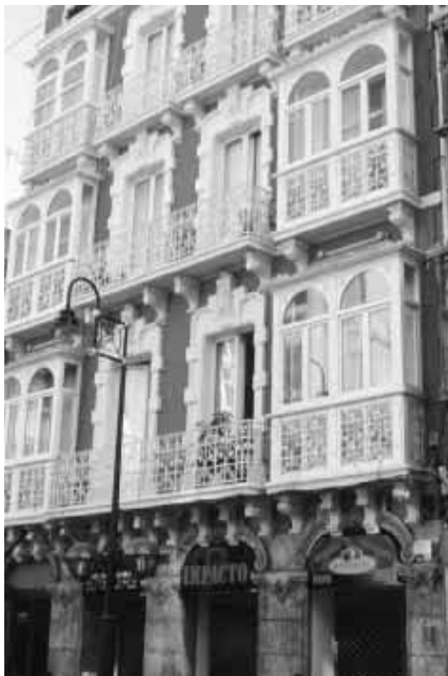
Figura nº 9. El Plan URBAN se ha convertido en un buen instrumento de recuperación de fachadas en los edificios más significativos. Una acertada remodelación y acondicionamiento de los más significativos edificios contenidos en el Catálogo.
