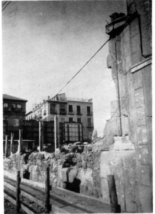
14.—Panorámica de la calle de los molinos, en que pueden apreciarse las ventanas de iluminación de las cuadras de los molinos. Obra de indudable interés artístico cuya incorporación a aquéllos se hizo a comienzos del s. XIX, una vez restauradas, por don Simón Adalid. Antes pertenecieron a la Posada del Puente.
