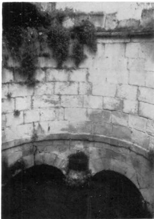
10 y 11.—Ambas fotos representan el colector de aguas, en la parte interior a las compuertas, junto al azud, puede observarse la disposición semicircular del muro almenado —junto a la esquina modelada del mismo—, con la bovedilla inferior de entrada del agua.
