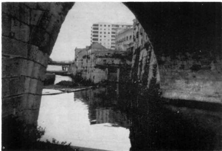
8.—Vista del azud y compuertas de la toma de agua para los molinos (al fondo); en que se aprecia la disposición oblicua del Puente, a la dirección de las aguas, prevista por el arquitecto, Toribio Martínez de la Vega.
