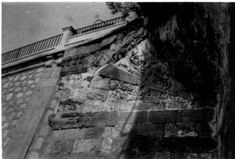
7.—Bovedilla en trompa en la parte septentrional del Puente Viejo. Forma de apoyo estilizada por Jaime Bort, que lo finalizó en 1742. Tres ménsulas sirven de comprobación, a la izquierda, del viejo muro de contención del río. Están señaladas, como prueba de la destrucción de los conventos, en la Desamortización, sobre uno de los sillares.
