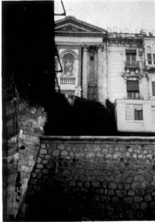
5.—Vista del estribo meridional; por el lado del Puente Viejo (opuesto al del azud) con la Ermita de los Peligros, al fondo de él nace el muro de contención que había de proteger el Matadero. Es, por tanto, anterior a las obras de canalización de Serrano y a los molinos del Puente Viejo.
