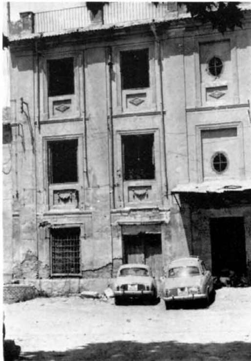
19.—Fachada de estilo neoclásico del llamado molino de las Heras, al pie de la llamada «cuesta de los molinos». Parece que sirvió hasta comienzos del presente siglo de Fábrica de Harinas.
