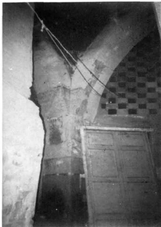
17.—Machón del arranque abovedado o nerviación en palmera. sostén de la bóveda, sexpartita. Uno de cuyos tramos sostiene.
