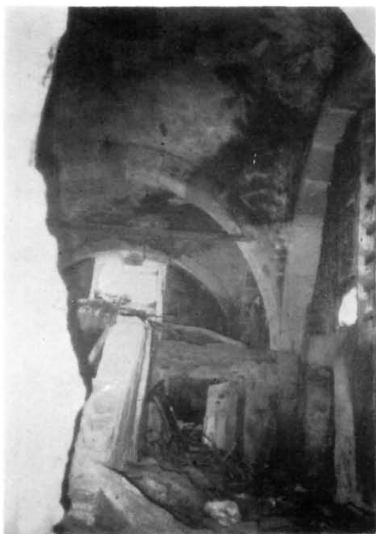
16.—Correspondencia interior de las ventanas en que puede apreciarse el magnífico abovedamiento, sobre machones, de que arcan los nervios sostén de la bóveda.
