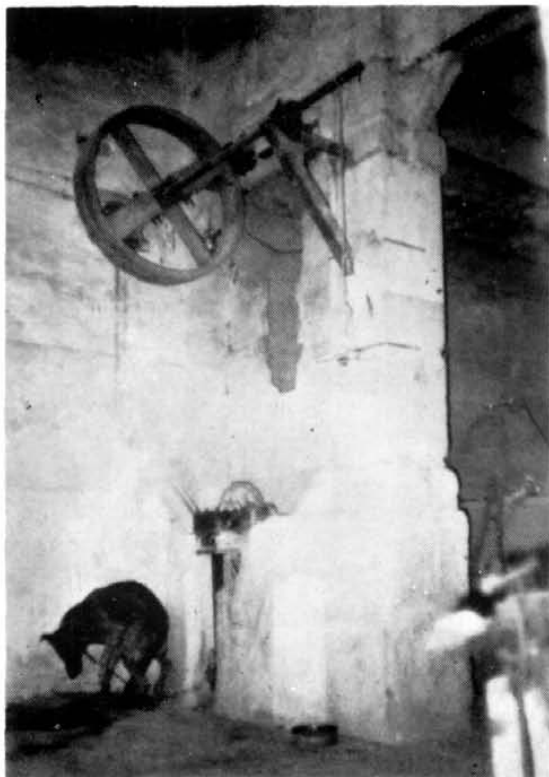
21.—Interior de uno de los molinos, donde aparece, junto a la ciclópea construcción pétrea, base de su primitiva fortaleza, una de las ruedas que servían de polea al funcionamiento de la maquinaria.
