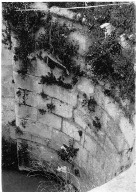
10 y 11.—Ambas fotos representan el colector de aguas, en la parte interior a las compuertas, junto al azud, puede observarse la disposición semicircular del muro almenado —junto a la esquina modelada del mismo—, con la bovedilla inferior de entrada del agua.
