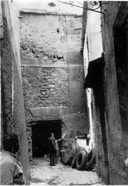
13.—Vista del callejón interior que sirve de acceso a las cuadras: puerta del fondo, bajo el muro primitivo. El autor de este trabajo, recibe algunas explicaciones de sus peculiaridades, por el único molinero actual en activo: Andrés Las Heras, junto a una de las piedras molineras. Compruébese en la transcripción del plano adjunto.
