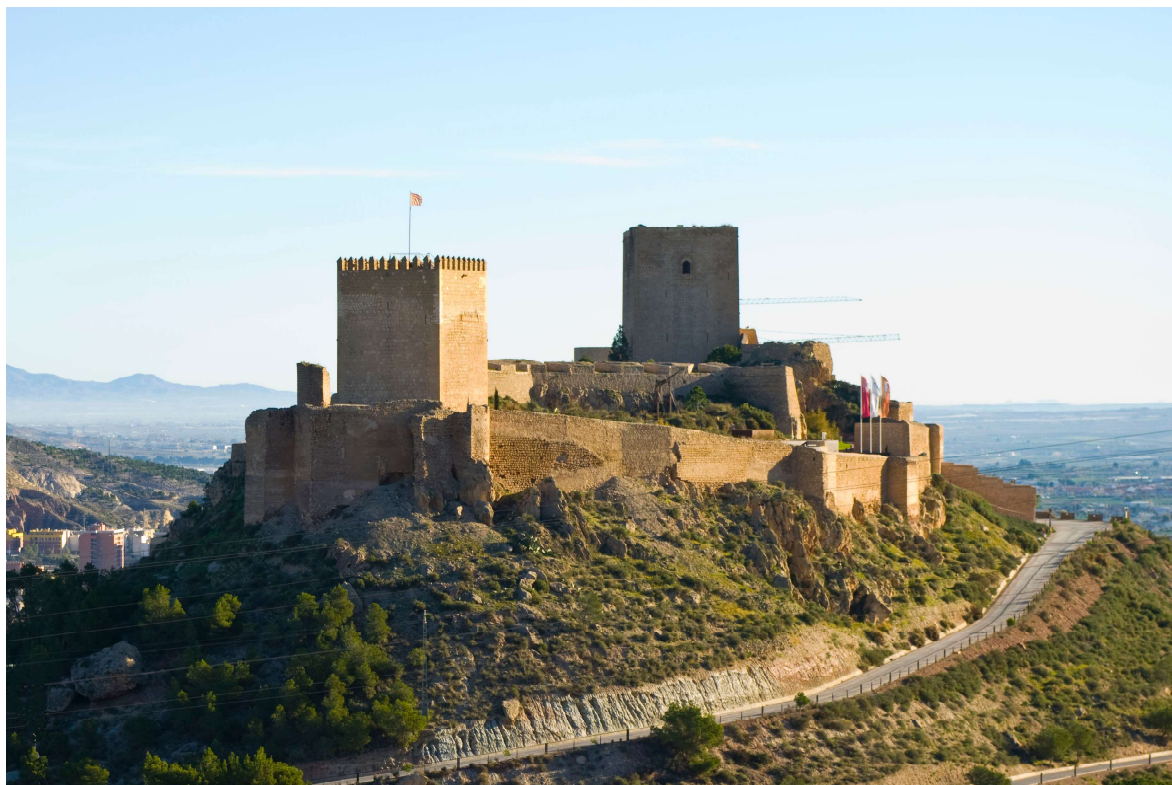
Figura 4. A la izquierda se observa la torre del espolón y a la derecha la Torre Alfonsina o Torre del Homenaje. Autor: José Lorca.
