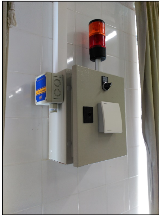
Figura 15. Sistema de alarma conectado al detector de formaldehído.
