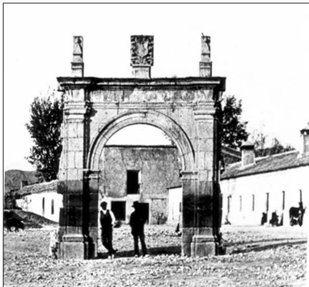
Fig. 2. Puerta principal del recinto ferial de Lorca. Demolida en 1903.
