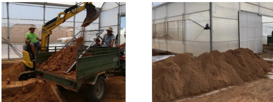
Figura 3.9: Retirada, cribado y homogeneización del suelo.
