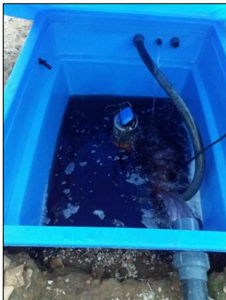
*Imagen 5.2. Oxigenación de SN en cuba mediante cascada del drenaje y recirculación.*
