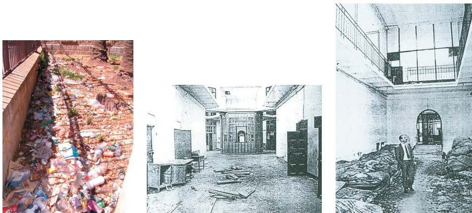
Figura 4 Planta baja de la Prisión Provincial de Murcia (patio exterior e interiores)
