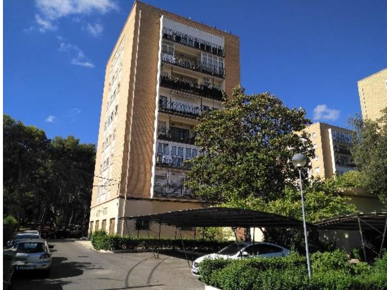
Fig.138. Detalle del grupo de viviendas
