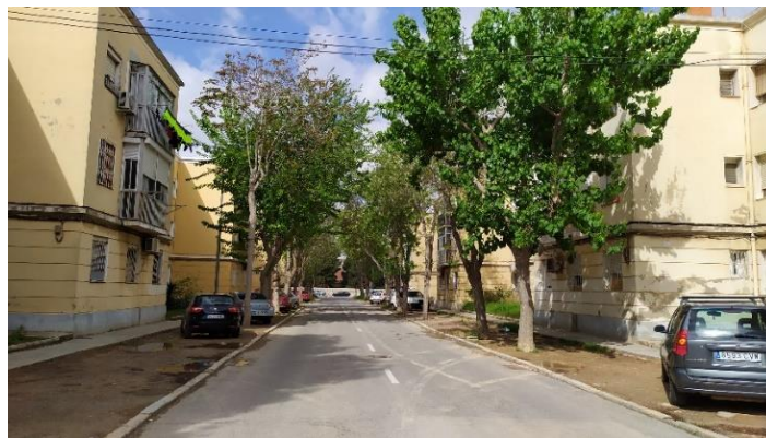
Fig.120. Vista de varios bloques
