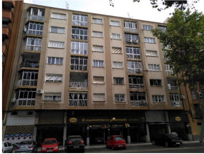
Fig.140. Bloque de 24 viviendas
