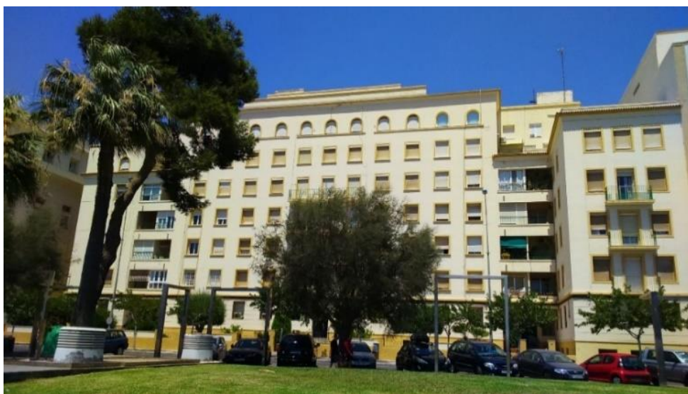
Fig.49. Vista actual del grupo de las viviendas.
