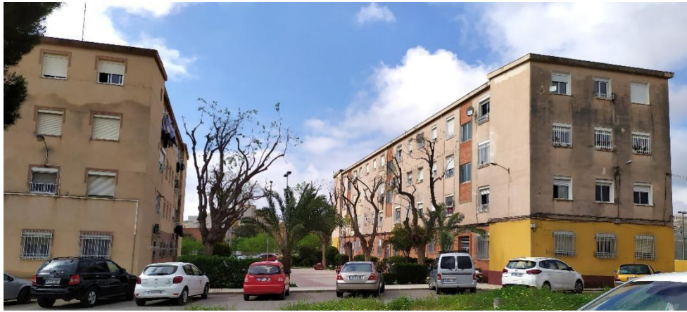
Fig.93. Fachadas principales y traseras del grupo de 40 viviendas
