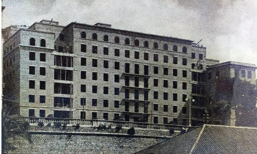
Fig.47. Construcción de 37 viviendas perteneciente al grupo de 48 viviendas.1950 [Fuente: Área de Patrimonio de la Delegación de Defensa en Cartagena]
