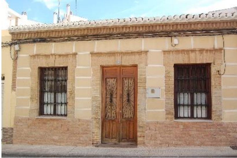
Fig.32. Estado actual de las viviendas repartidas por la Maquinista de Levante La Unión
