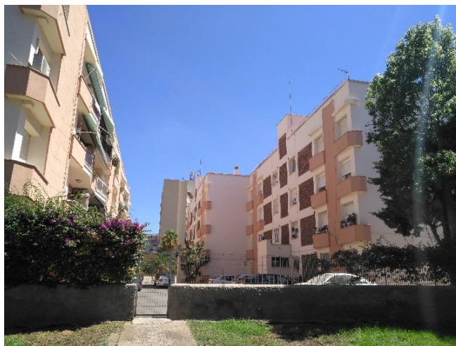
Fig.149. Grupo de viviendas
