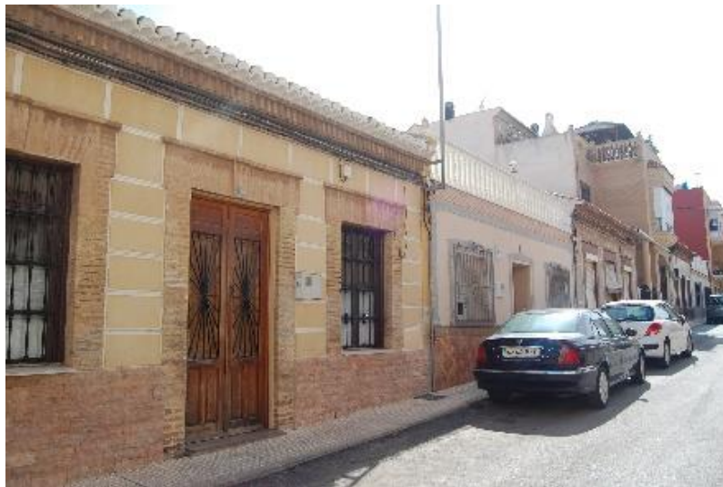
Fig.33. Hilera de las viviendas de la Maquinista de Levante. La Unión
