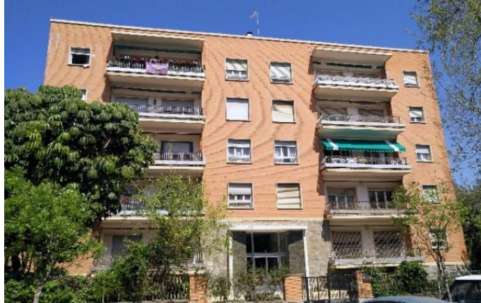
Fig.118. Bloque existente de la calle Trafalgar.
