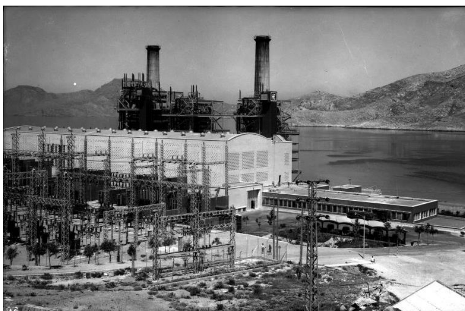
Fig.26. Vista de la central térmica de Escombreras en Cartagena. [Fuente: Archivo General de la Región de Murcia, FOT_NEG,057/013.]
