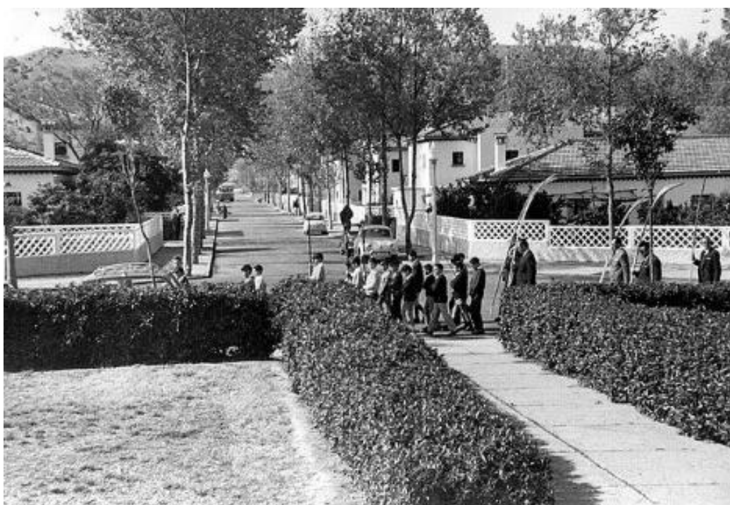
Fig.127. Viviendas tipo 11S de la calle Sol. [Fuente: Ibeas Romero, C. https://poblado.mforos.com/179974/9308210-la-arquitectura-de-mi-pueblo-y-su-maqueta/?pag=4
