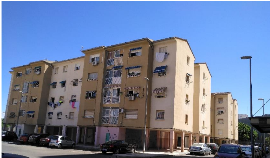
Fig.101. Grupo de viviendas T-72 ubicadas en la calle Rivera de San Javier.
