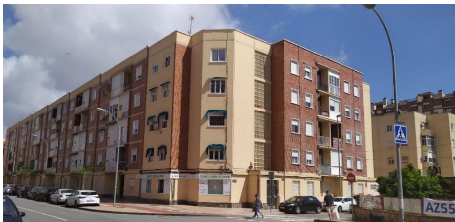
Fig.75. Fachadas de las calles Santiago Ramón y Cajal y Poeta Miguel Hernández
