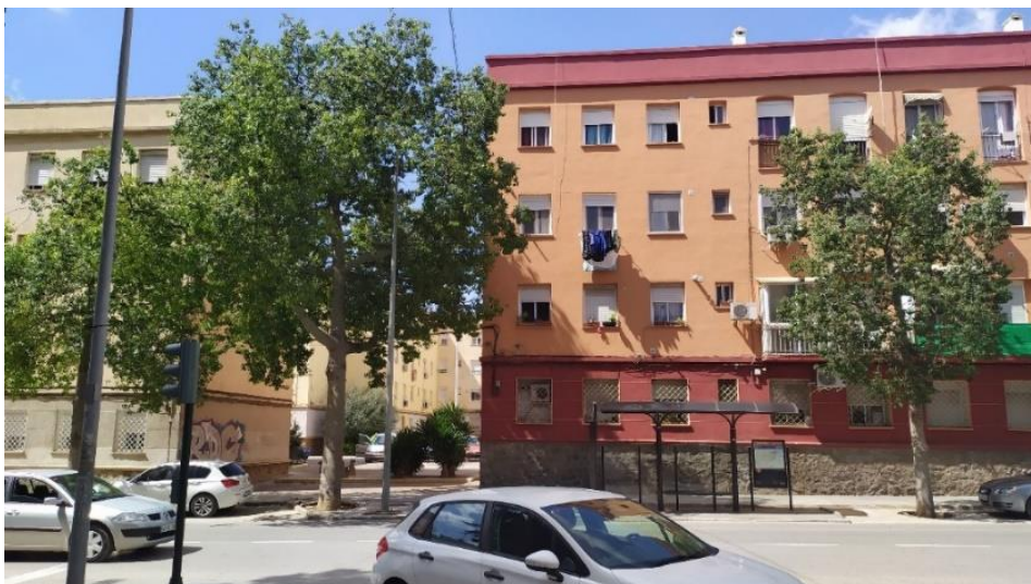
Fig.70. Vista del grupo de viviendas
