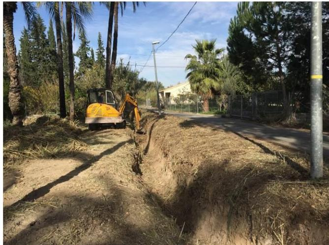
**Figura 4.** Reapertura del Azarbe del Cantino.
